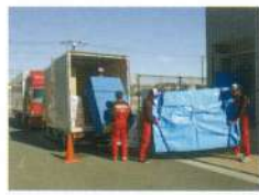
▲積み込み作業
