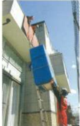
◀高所での作業
